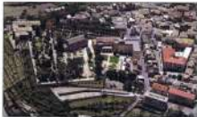
Figura 104. Veduta aerea del Giardino Italo e del suo ampliamento.
