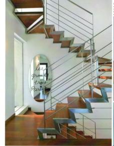
LA SCALA, POSTA LATERALMENTE RISPETTO ALL'ASSE PRINCIPALE DELLA CASA, È UN ELEMENTO VOLUTAMENTE LEGGERO, CON L'UTILIZZO DI STRUTTURA E RINGHIERE MOLTO SOTTILI IN ACCIAIO, LE PEDATE IN TEAK CON IL LATO LUNGO INCLINATO A DARE DINAMICITÀ
