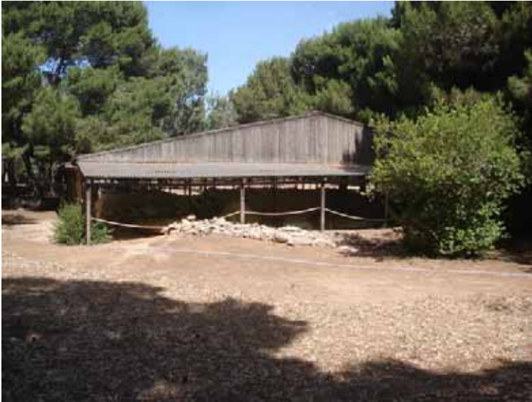
La copertura esistente
