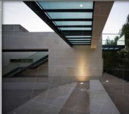
Viata della passerella dal basso
