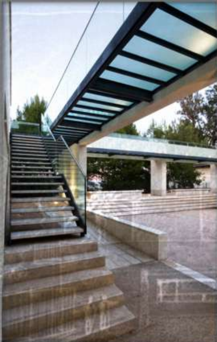
Vista dalla scala di accesso alle passerelle
